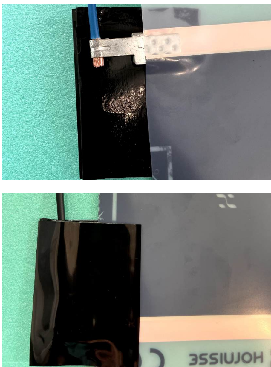
Zdjęcie 10. Miejsce izolacji folii z konektorami AC4 (góra i dół).
